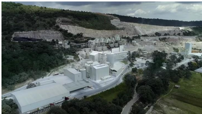
Figura 2.1 Horno de calcinación, Puebla, México.
