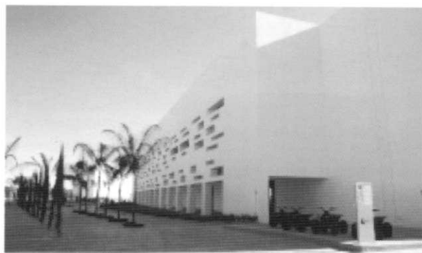
Edificio Norte 2. Centro de Convenciones, Centro de Consultoría.
