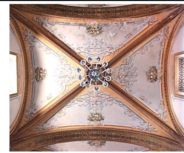
Fig. 1 Bóveda en nave, recubierta de pintura mural a la cal (Autor: Luis Gutiérrez, 2021).
