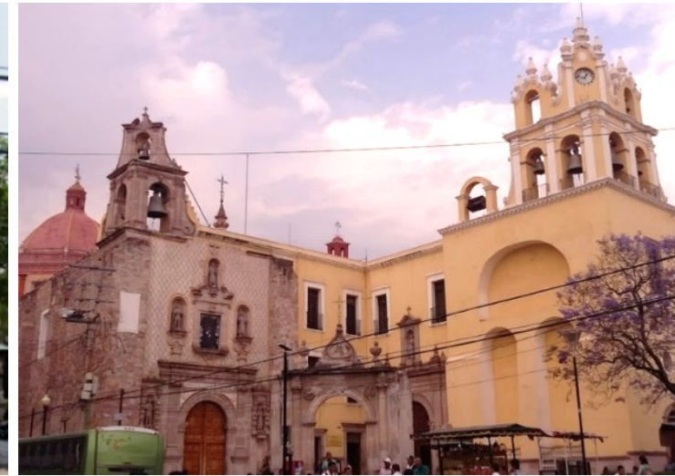
Figura 10. Capilla de la Tercera Orden (izquierda) y Templo de San Diego (derecha). Aguascalientes. (Autor: Flores, 2016).
