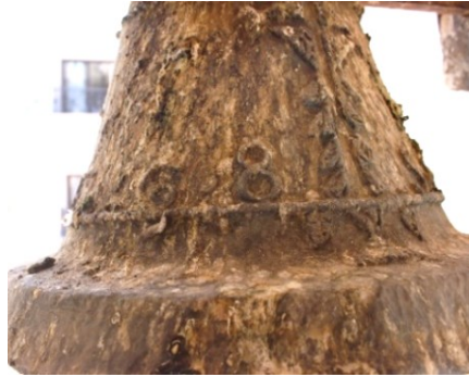
Figura 82. Depósito de guano sobre campana en espadaña (Autor: Luis Gutiérrez, 2021).
