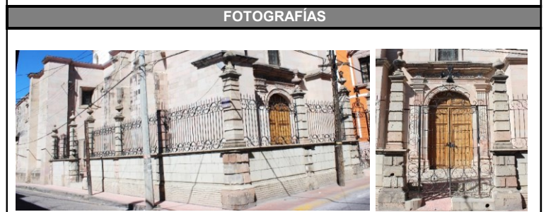
Fig. 1. Vista de barda atrial desde intersección de Calle Minerva y Morelos (Autor: Luis Gutiérrez, 2021).
