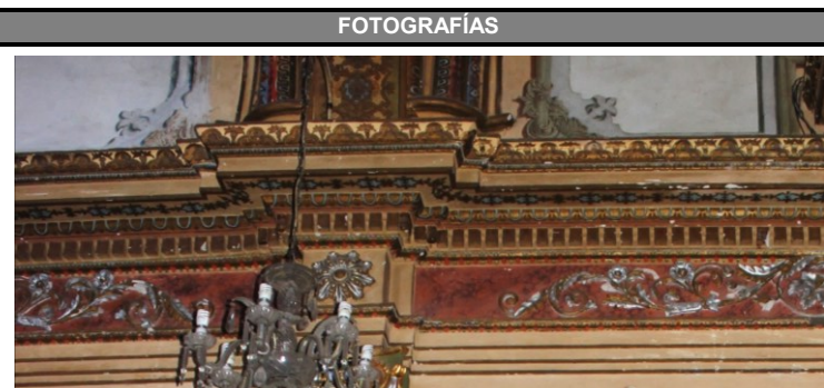
Fig. 1 Detalle de cornisa recubierta de policromía de pintura a la cal y ornamentos en altorrelieve (Autor: Luis Gutiérrez, 2021).
