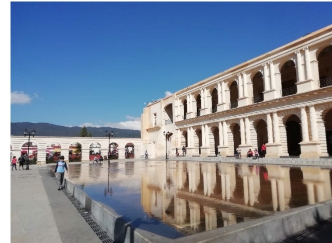
Figura 17. Antiguo Palacio Municipal de San Cristóbal de las Casas, actualmente Museo de San Cristóbal, tras su restauración. (Autor: Luis C Cubica Arquitectos, 2017).
