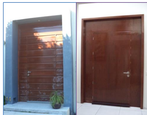
Puerta Principal de cedro. Vista exterior - interior
