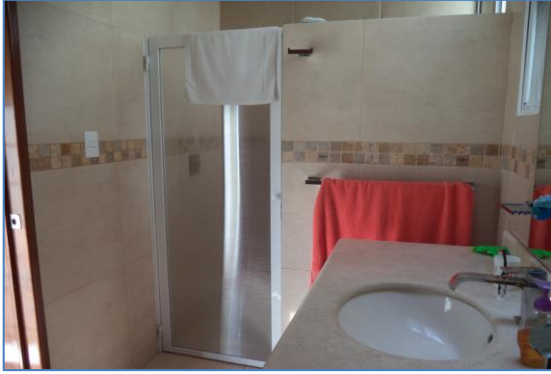
Cancelería de vidrio y aluminio, muro divisorio con cerámica para regadera
