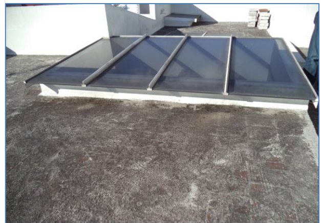
Domo en azotea, con posibilidad de usar como roof garden la azotea
