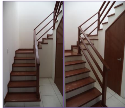
Escalera de concreto armada con huella y barandal de madera
