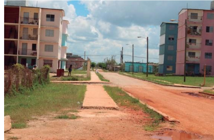
Calles sin pavimentar en el Barrios Los Coquitos. Fuente: M. Sarabia, Marzo, 2019
