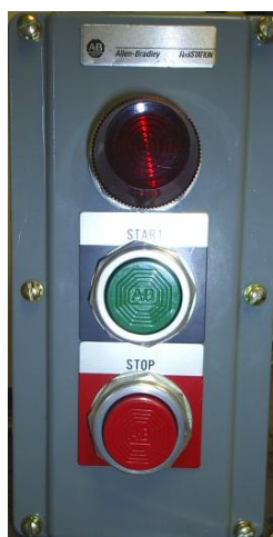
Figura 67: Prueba de que la luz piloto apagada cuando el voltaje presenta un decrecimiento.
