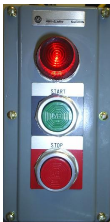
Figura 66: Muestra física de la luz piloto y botones de paro y arranque.
