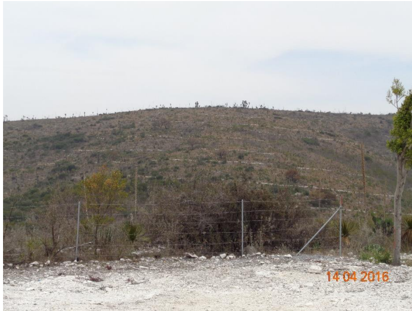
Figura 25. Zona de muros de contención. Fotografía de: Ramírez-García, A.
