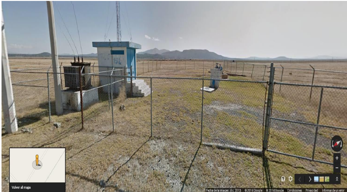
FIG. 1.13 POZO 13 FOTOGRAFÍA TERRESTRE
