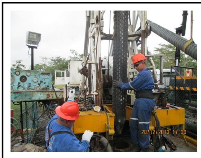
FOTOGRAFÍA 4.4 COLOCACIÓN DE TUBERÍA RANURADA.
