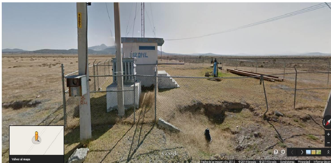
FIG. 1.15 POZO 14 FOTOGRAFÍA TERRESTRE
