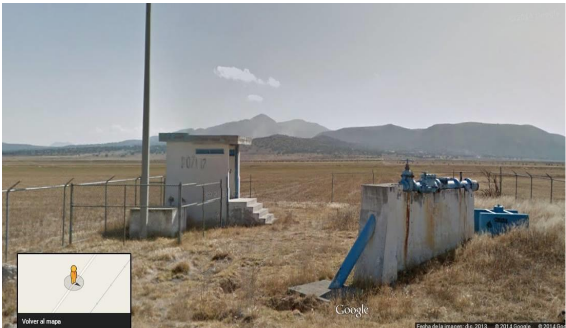
FIG.1.11 POZO 12 FOTOGRAFÍA TERRESTRE
