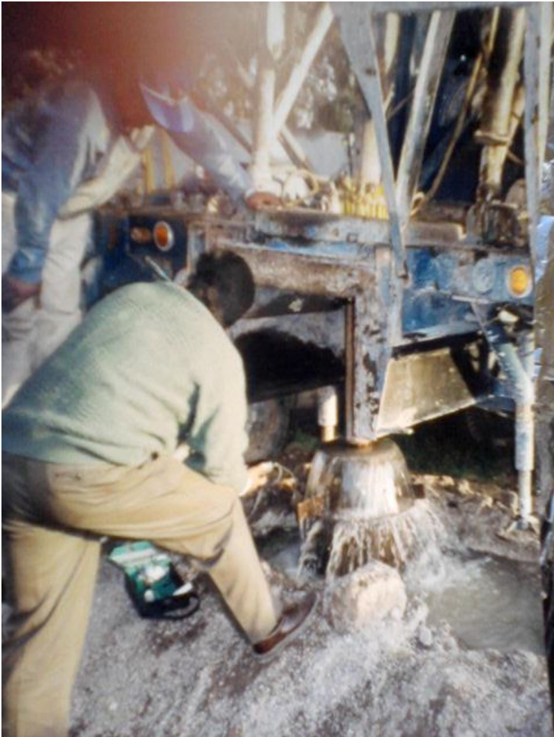
FOTOGRAFÍA 4.2 LAVADO DE POZO.
