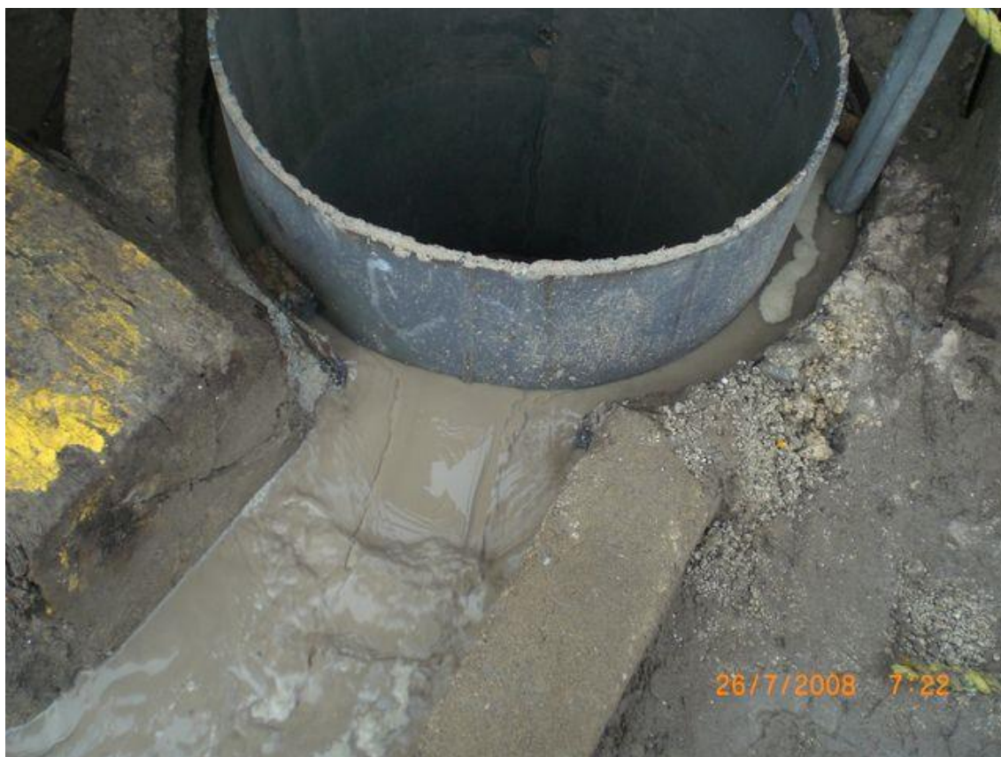
FOTOGRAFÍA 4.3 Colocación del contraademe sanitario.
