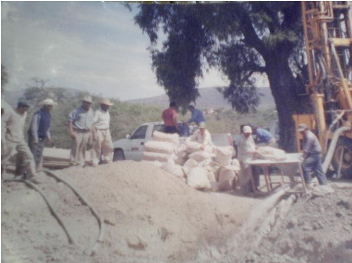
Fotografía. 3.2 Preparación de lodo bentonítico con embudo agitador.
