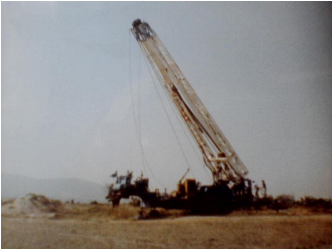
Fotografía. 3.1 instalación de equipo de perforación.
