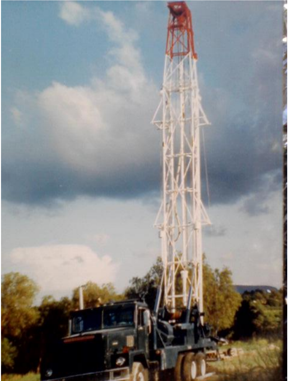
Fotografía. 3.3 PERFORADORA ROTARIA DE CIRCULACIÓN DIRECTA FAILING 2000
