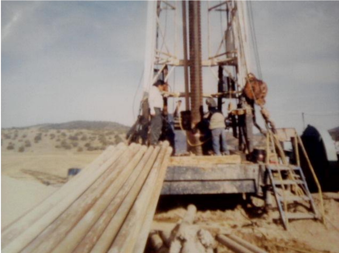
FOTOGRAFÍA 4.5 ADEMADO DE POZO.
