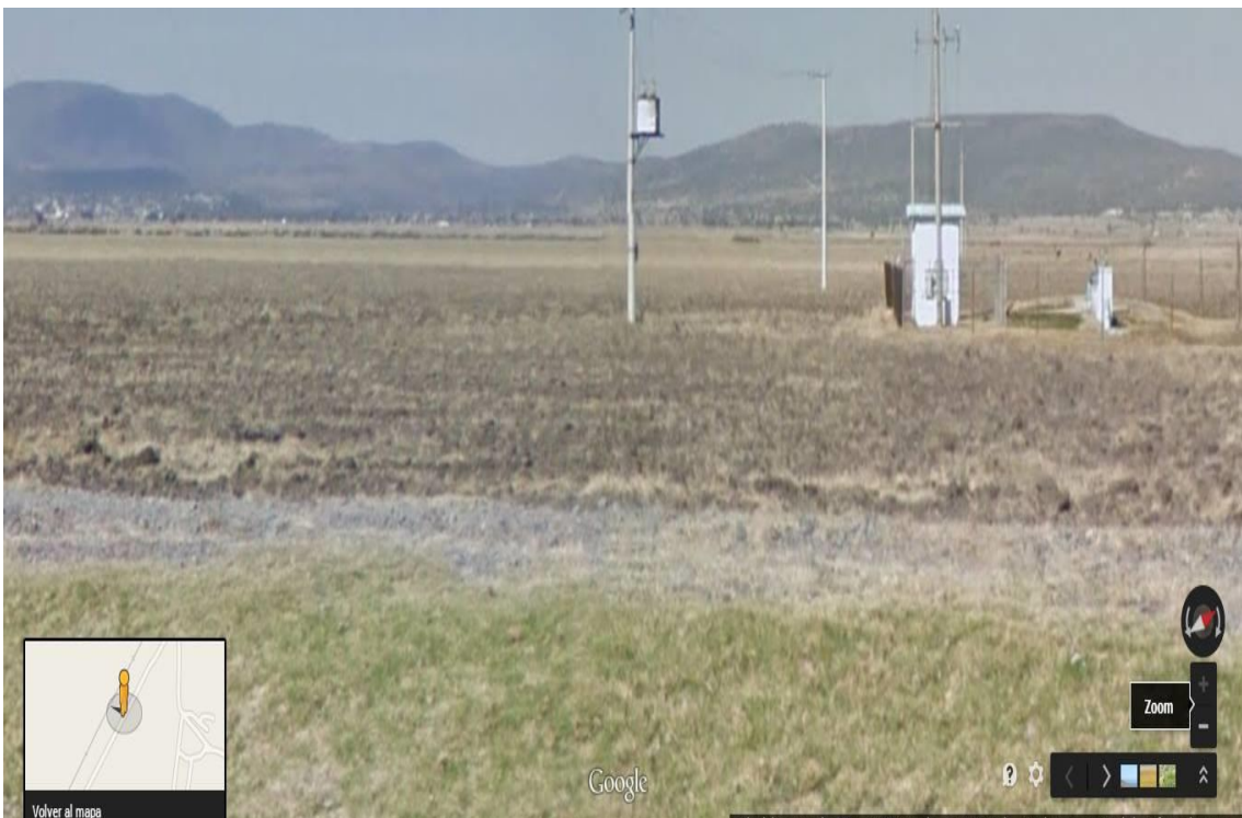
FIG. 1.5 POZO 9 FOTOGRAFÍA TERRESTRE
