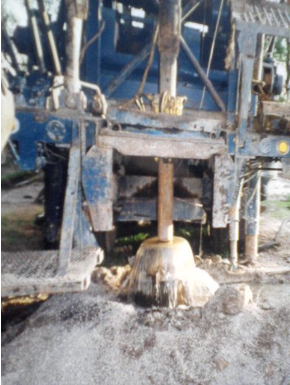
FOTOGRAFÍA 4.1 LAVADO DE POZO.
