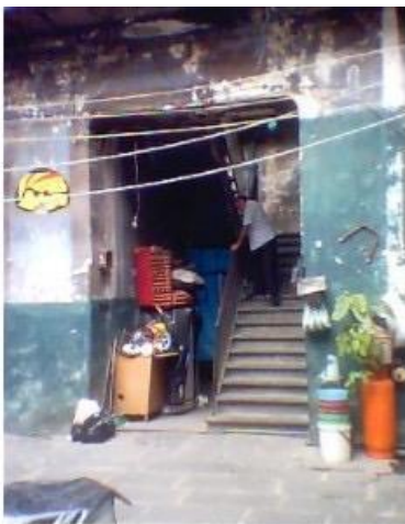
Escaleras del segundo patio
