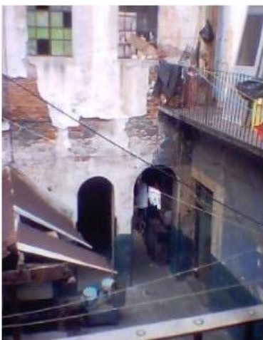
Acceso a segundo patio
