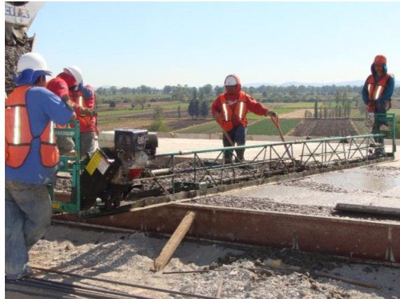
Figura 2.2 Pavimentación rígida (Elaboración propia, 2009).
