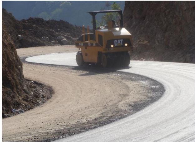
Fig. 2.1 Pavimentación flexible, (elaboración propia, 2013).
