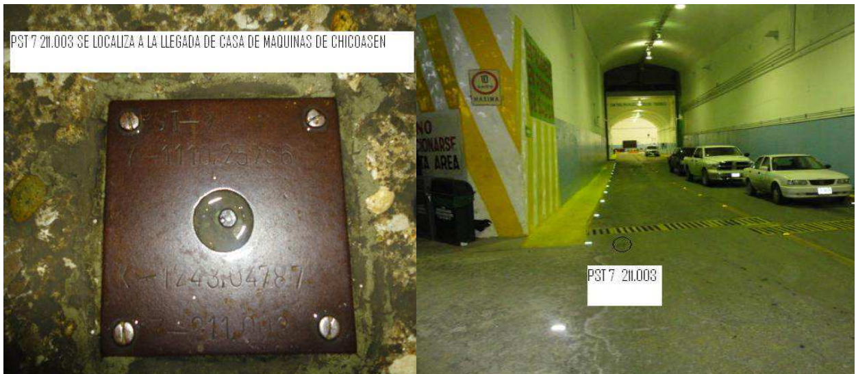
Banco de nivel Patrón “PST-7” en Casa de Maquinas, C.H. Chicoasén.
