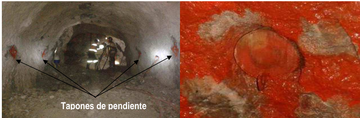
Colocación de tapones
