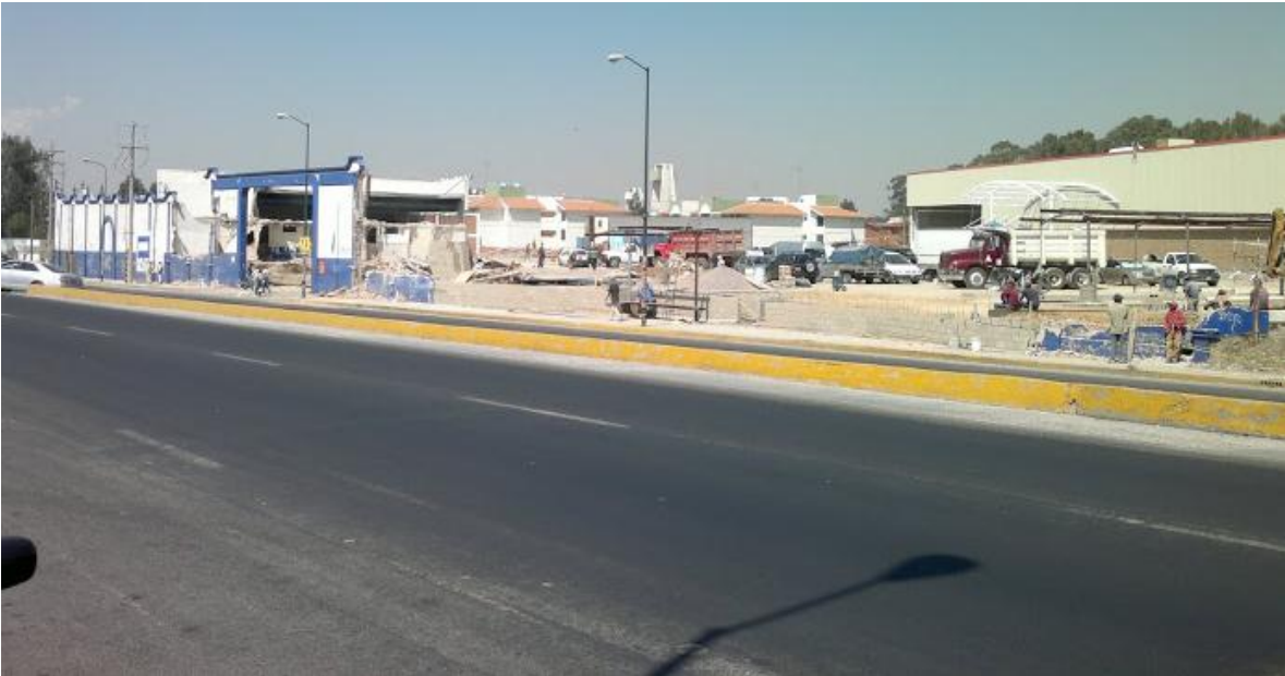
Ilustración 38. Fotografía 2, demolición de la bodega "Corona" año 2010-2011
