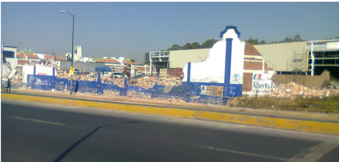
Ilustración 37. Fotografía de la demolición de la bodega "Corona" Año 2010-2011
