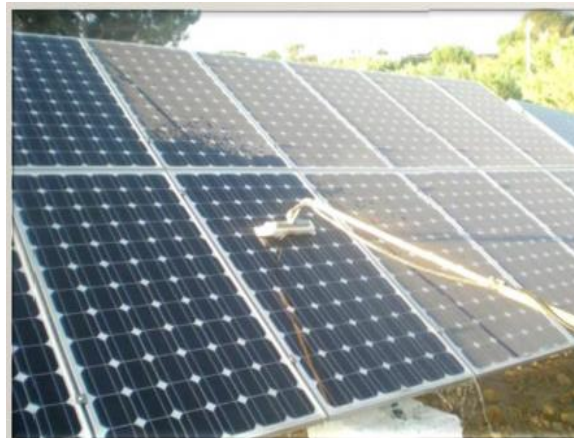
Figura 5.44 limpieza de módulos fotovoltaicos.
