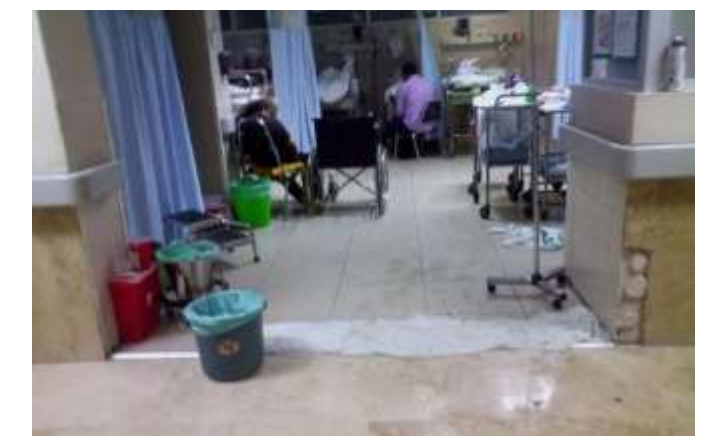
Figura 1.1.2. Hospital General 11 del IMSS. Nuevo Laredo, Tamaulipas Fuente: Imagen de Internet
