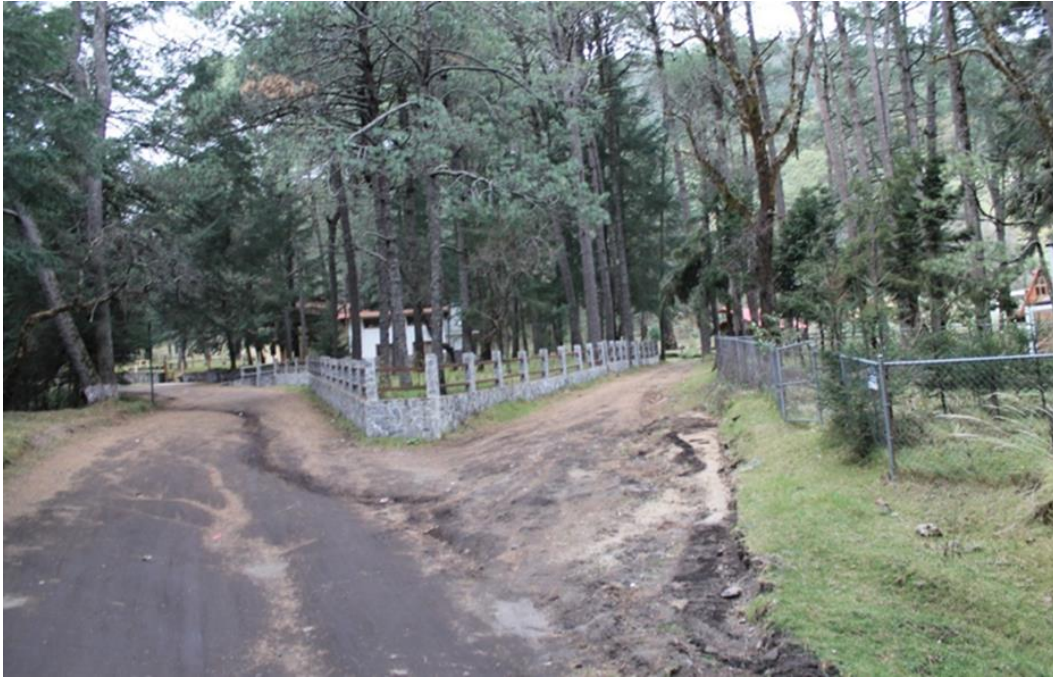
Ilustración 67: Inestabilidad y erosión por infraestructura sin presencia de mantenimiento en las vías al interior del FBVT, Fuente: Registro Fotográfico febrero 2016, Foto: Gonzalo A. Torres Z.
