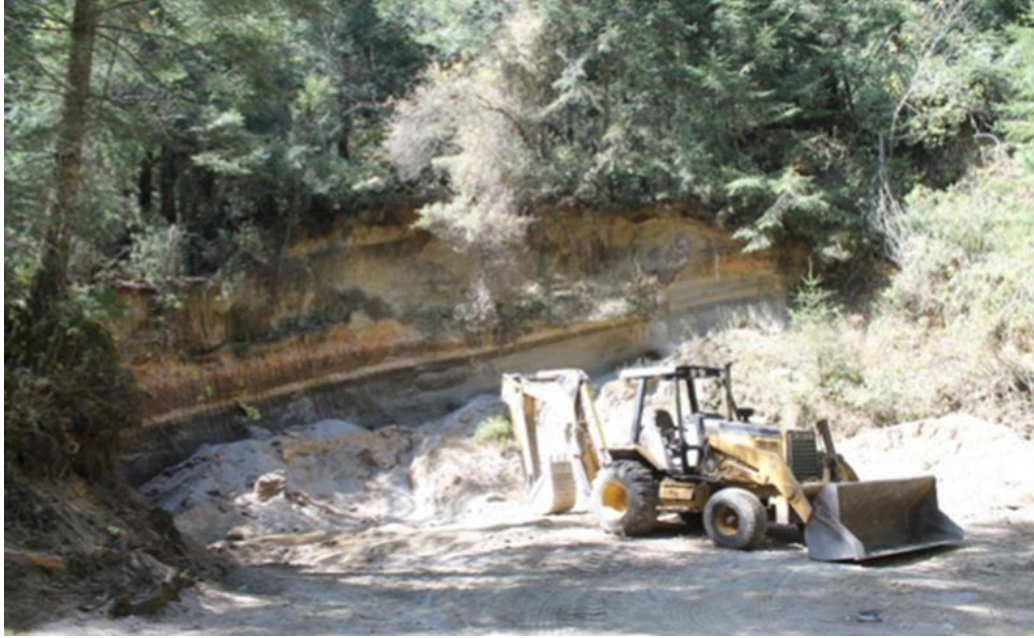
Ilustración 53: Maquinaria utilizada para la extracción de agregados por la Constructora Posada al interior del FBVT, Fuente: Registro Fotográfico febrero 2016, Foto: Gonzalo A. Torres Z.
