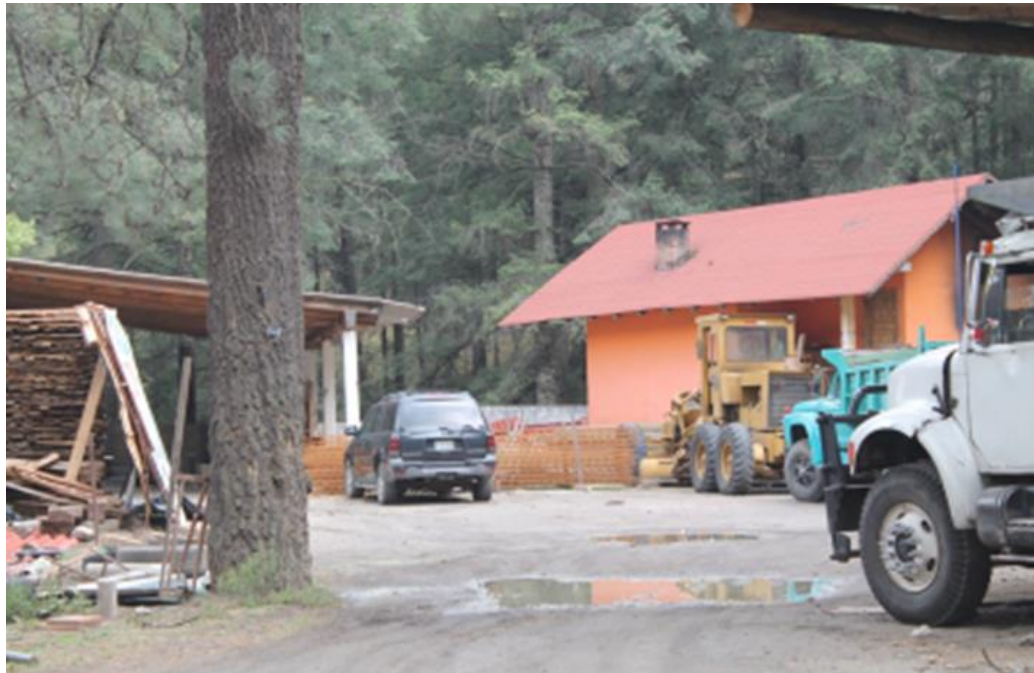
Ilustración 54: Maquinaria para ser usada por la Constructora Posada al interior del FBVT, Fuente: Registro Fotográfico febrero 2016, Foto: Gonzalo A. Torres Z.
