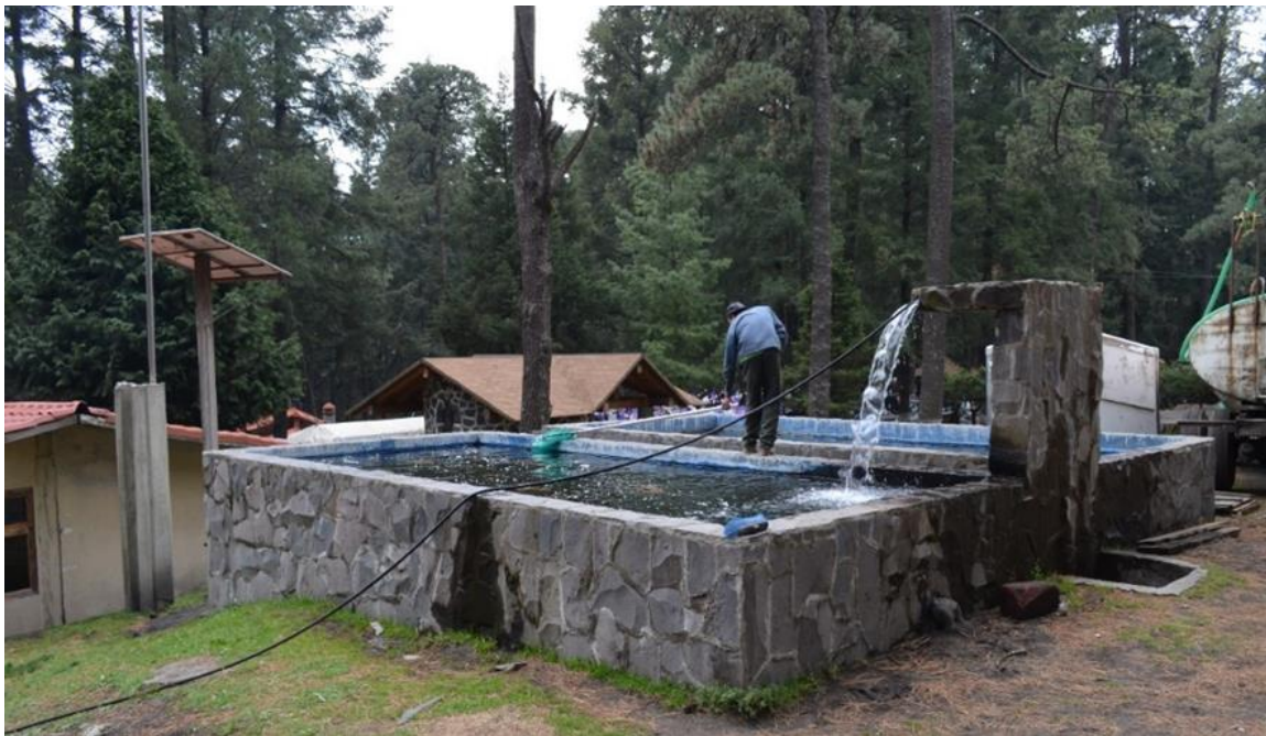
Ilustración 72: Servicios generales mantenimiento de tanques para captar agua de cuenca y manejo de peces, Fuente: Registro Fotográfico, febrero 2016, Foto: Gonzalo A. Torres Z.
