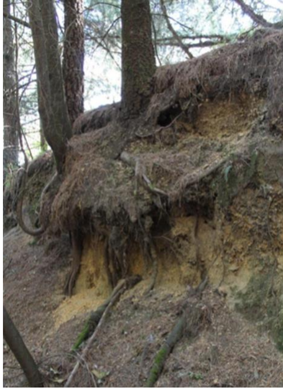
Ilustración 65: Desnivel en el terreno para lotificación de los predios, exponen las raíces de los arboles especie Pino Encino y erosionan la cobertura del suelo y subsuelo, Fuente: Registro 15 de abril de 2017, Foto: Gonzalo A. Torres Z.
