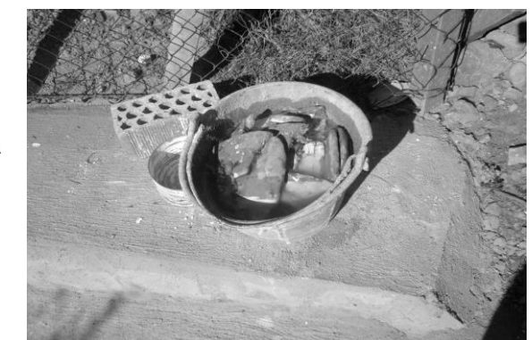
4.2.5.1 Proceso De Preparación De Impermeabilizante Natural
