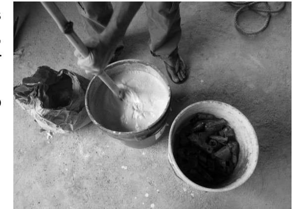
4.2.4.1 Preparación De Pintura e Impermeabilizante Natural
