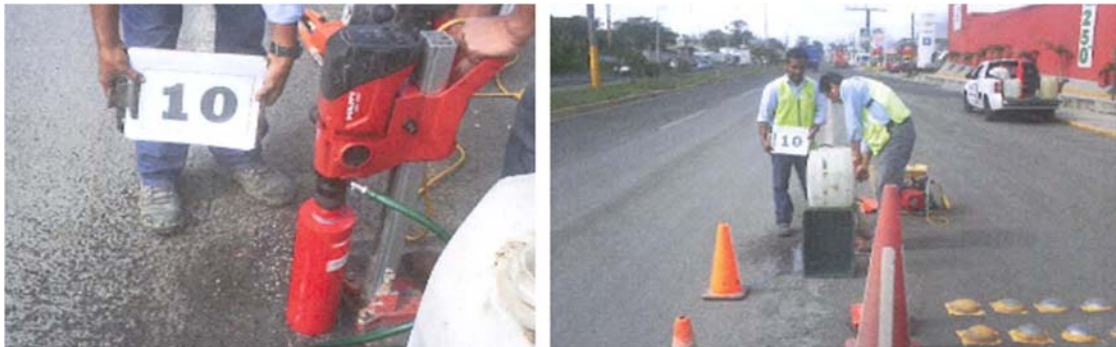
Imagen 3-12 Calas a la altura del kilómetro 4+500.00
