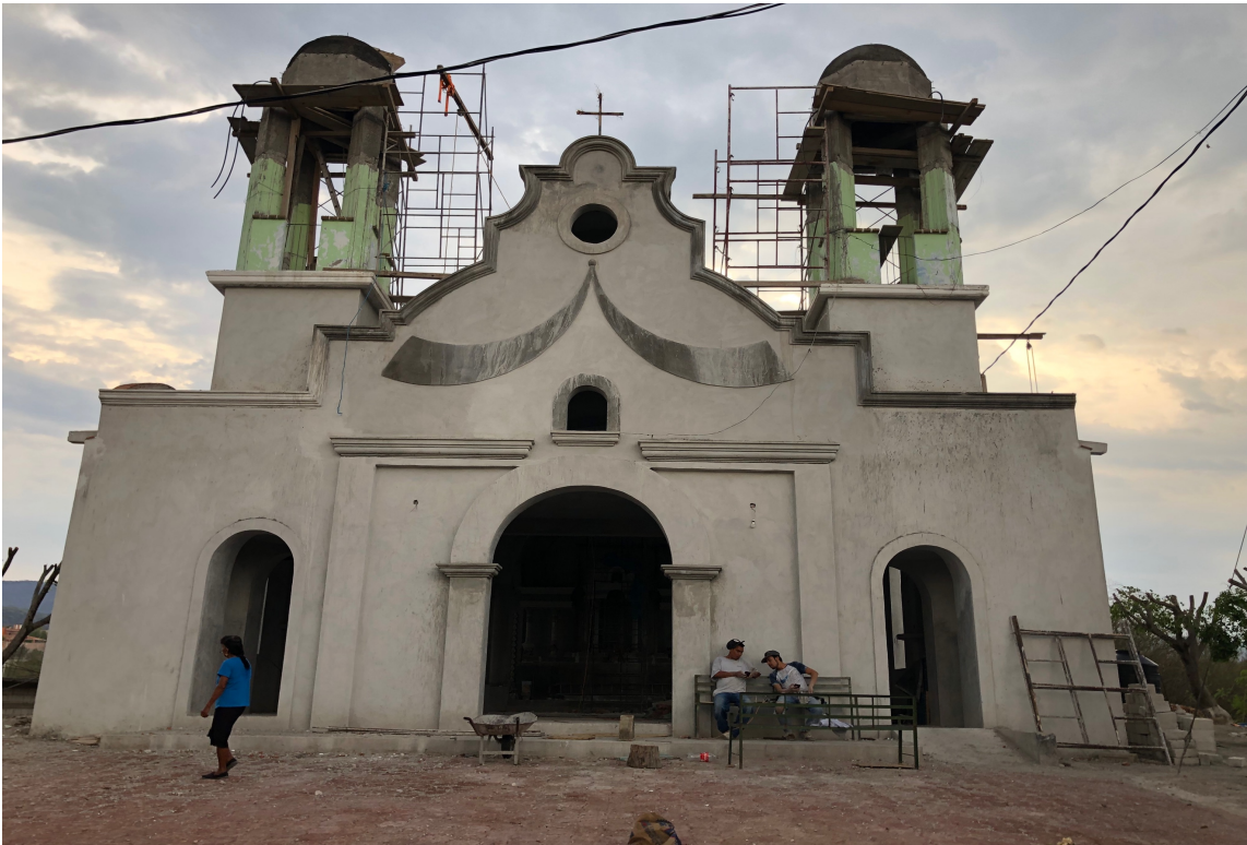
Reconstrucción de iglesia de la Junta Auxiliar, donde participan todos los migrantes que son originarios de la localidad y que se encuentran radicando en diversos lugares en Estados Unidos [Fotografías de Karla González]. (Junta Auxiliar San Francisco de Asís, 2019). Tehuitzingo, Puebla, México.
