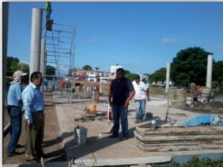
Visita a obra del C. Presidente José de la Torre a la construcción de canchas.
