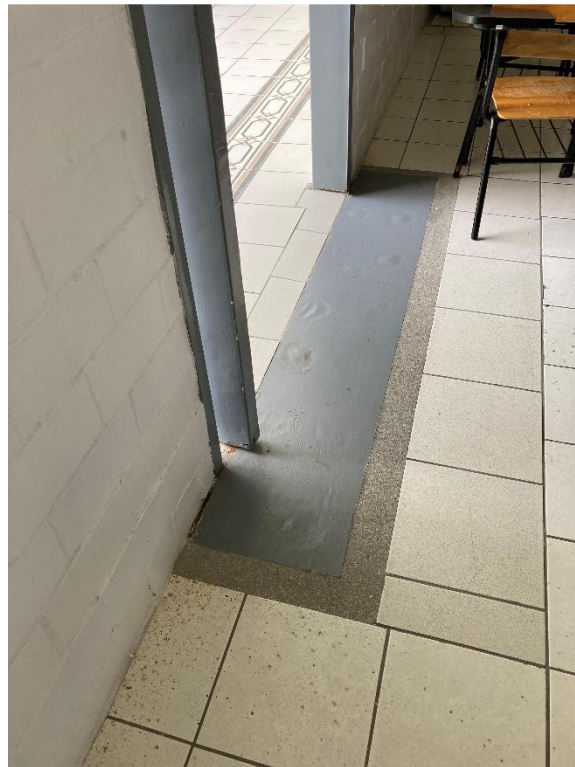
Figura 1.20. Placa superior de conexión de contraviento excéntrico del nivel inferior en losa. Fuente autoría propia, 2022.
