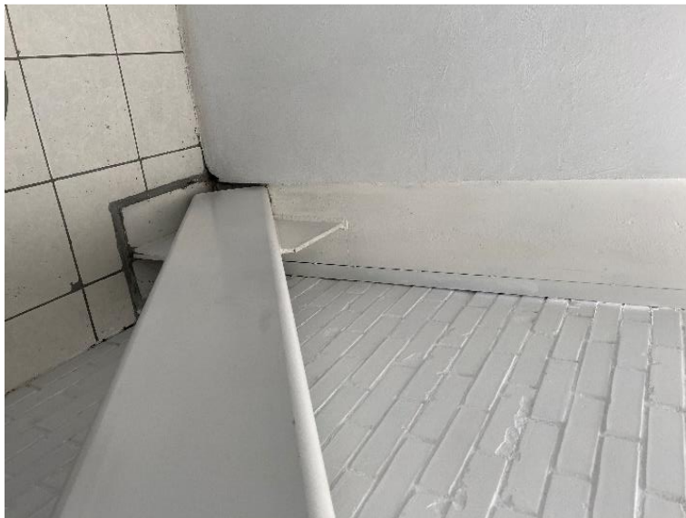
Figura 1.18. Conexión del contraviento en su extremo inferior hacia la columna y losa. Para el caso de la placa horizontal, no se observa algún sistema de anclaje hacia la losa, ni tampoco reforzamiento local. Fuente autoría propia, 2022.
