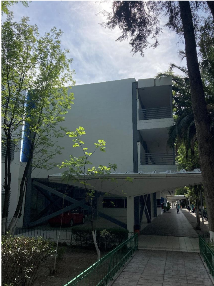
Figura 1.2. Vista lateral del edificio ING-4. (Fuente autoría propia, 2022)
