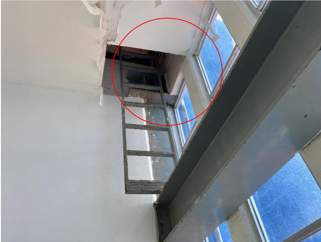
Figura 1.7. Fotografía que muestra el capitel de acero para la conexión de la losa. Fuente autoría propia, 2022.
