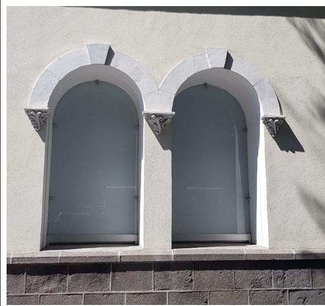
Ventanas inferiores de la fachada de la antigua penitenciaría.
