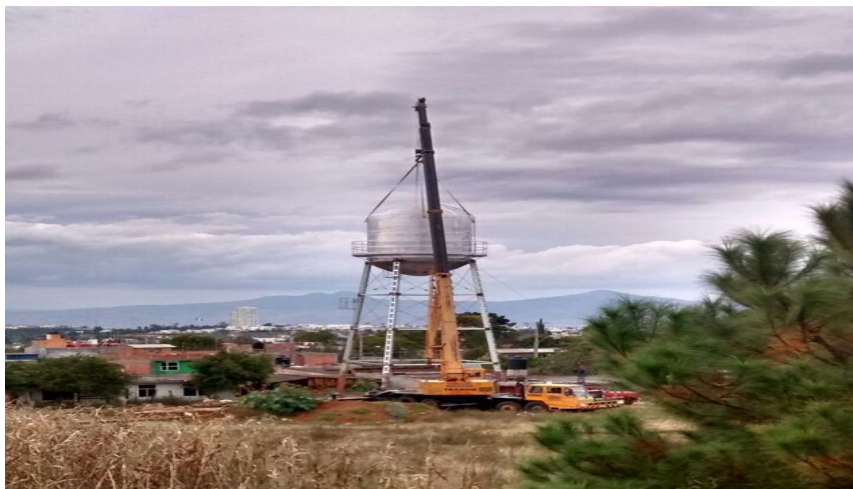
Fotografía 15. Instalación de tanque elevado, 2015. Fuente:
