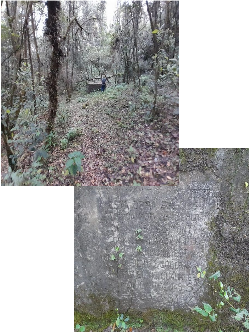
Fotografía 5. Caja de agua "El peral" . Caja de agua "El Peral" / Inscrito: "Esta obra fue construida por el pueblo de Jesús del Monte con cooperación del Estado, siendo gobernador el Lic. Cuauhtémoc Cárdenas S. 23-8-83". Fuente: Autoría propia
