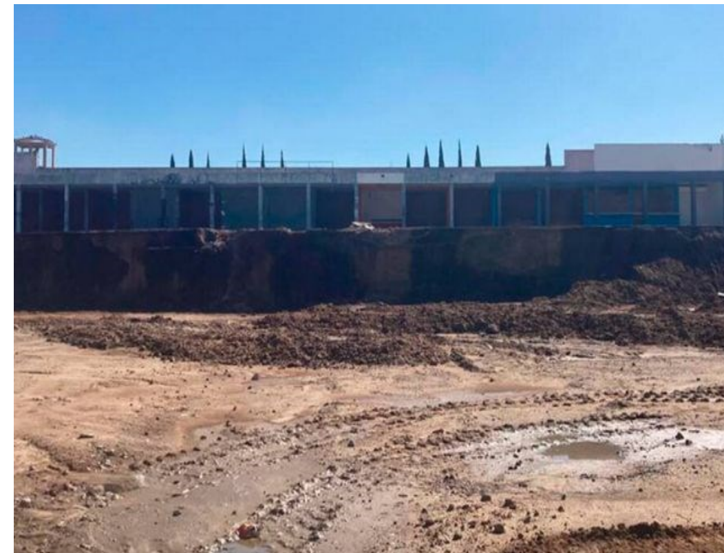
Figura 17. Imágenes durante la construcción del mercado
