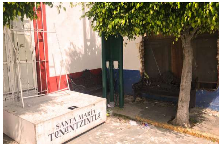
Figura 78. Bancas ubicadas en la plaza central, se puede observar cómo el poste y árbol obstruyen el paso.
