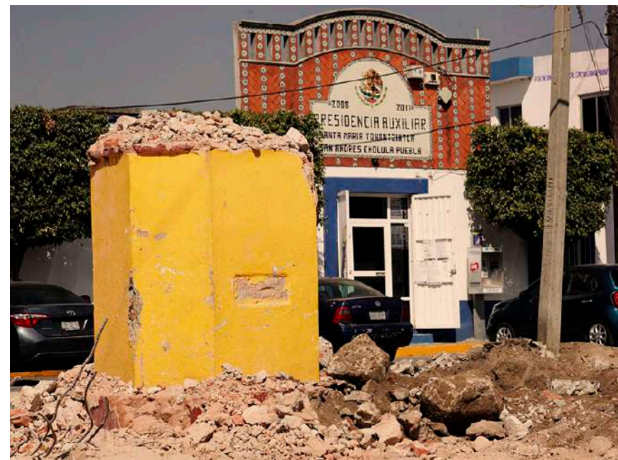
Figura 38. Ejecución de la obra Barrio Smart en Santa María Tonantzintla, Puebla 01. Imagen recuperada del sitio web www.facebook.com/TODOSPorTonantzintla
