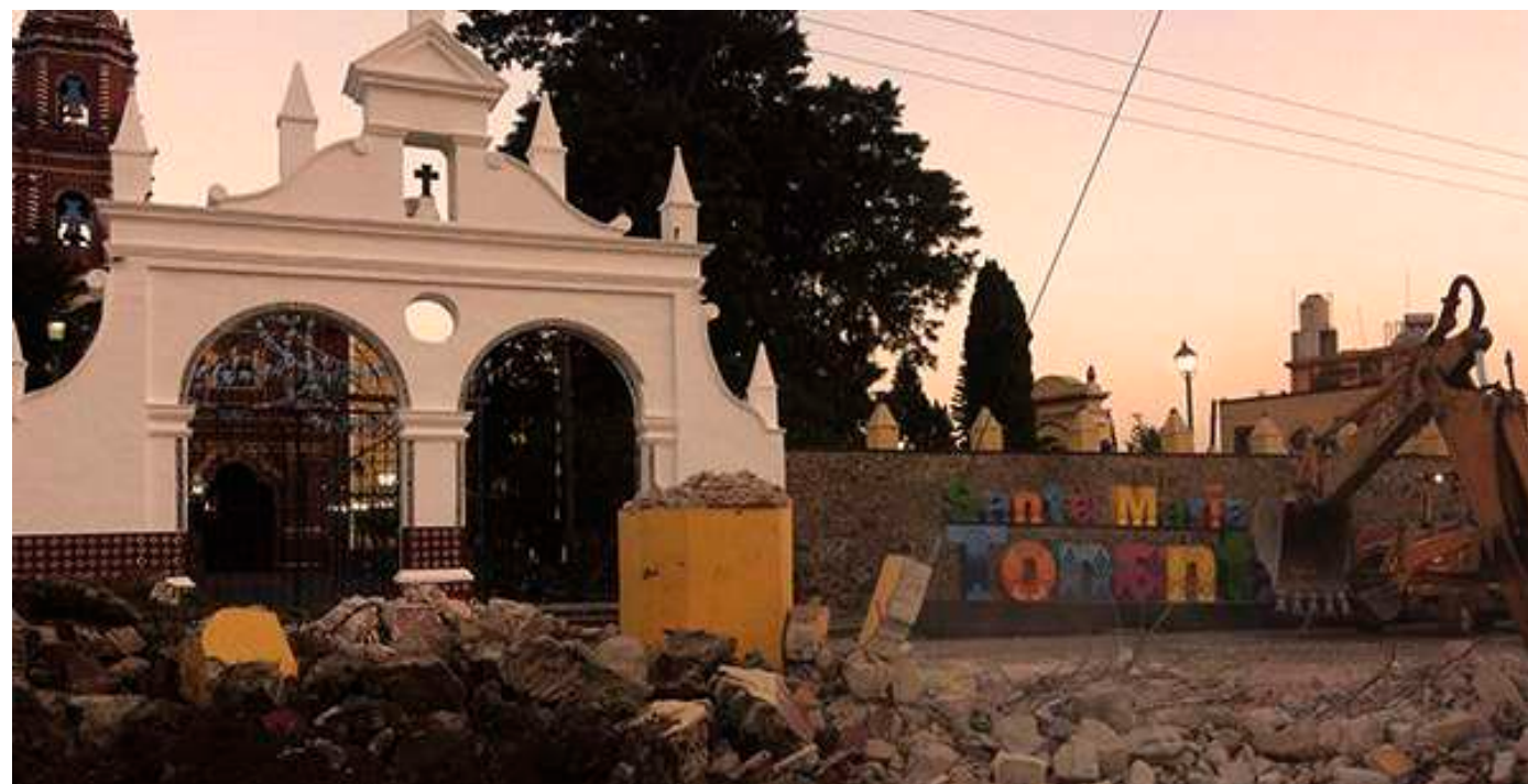
Figura 40. Ejecución de la obra Barrio Smart en Santa María Tonantzintla, Puebla 03. Imagen recuperada del sitio web www.facebook.com/TODOSPorTonantzintla
