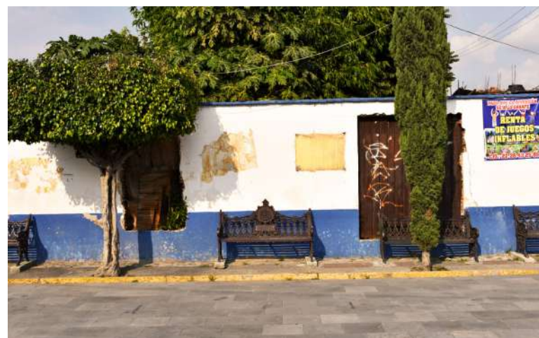
Figura 79. Huecos presentes en uno de los muros adyacentes a la plaza.
