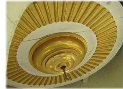
Imagen 9. Deterioros en madera
