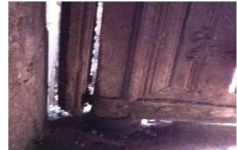
Imagen 2. Separación en base de soporte principal
