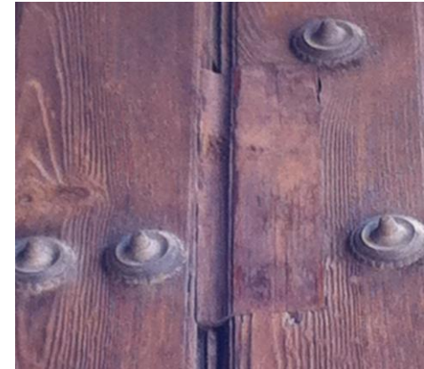
Imagen 18. Injerto de madera sobre listones de cubierta
