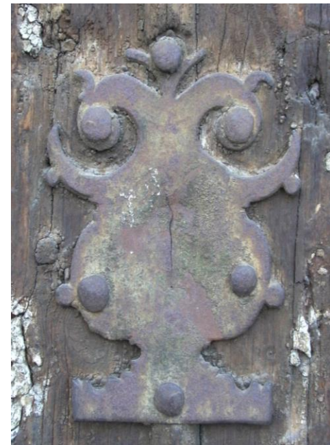
Imagen 16. Ojal de cerradura exterior, deformado intencionalmente
