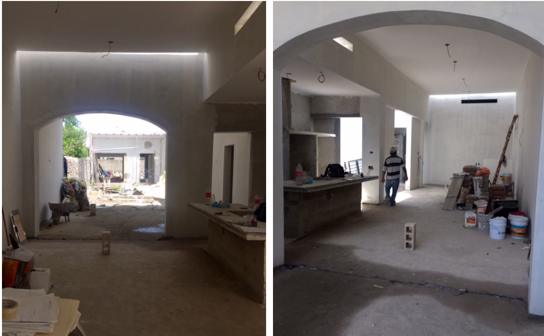
Fig. 18b: Obra en remodelación (interiores) Fuente: IAMQ
