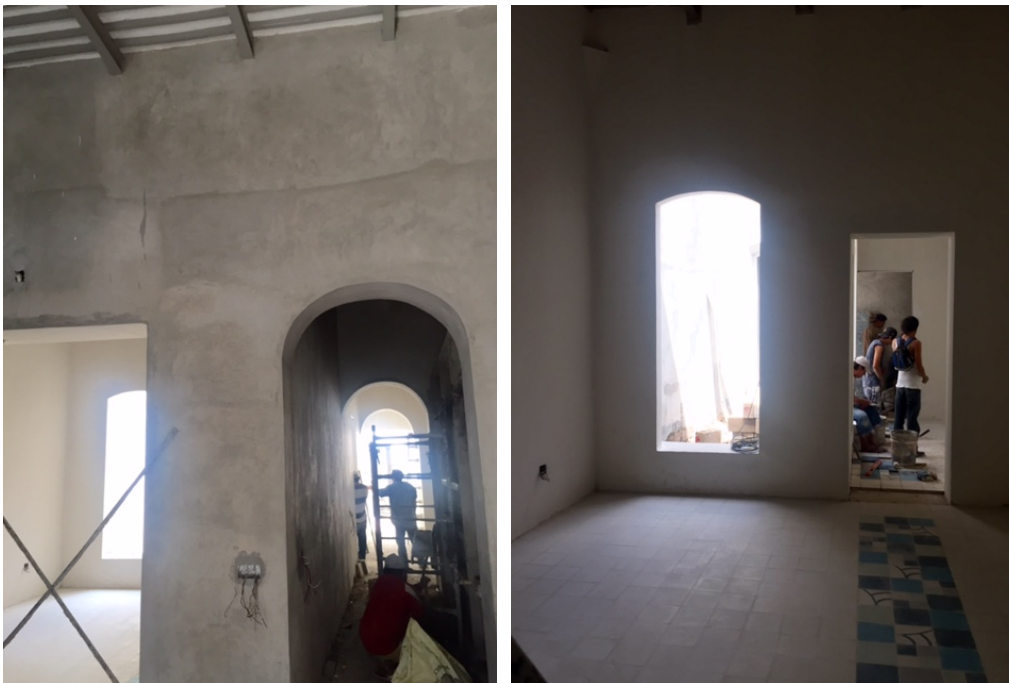
Fig. 18a: Obra en remodelación (interiores) Fuente: IAMQ
