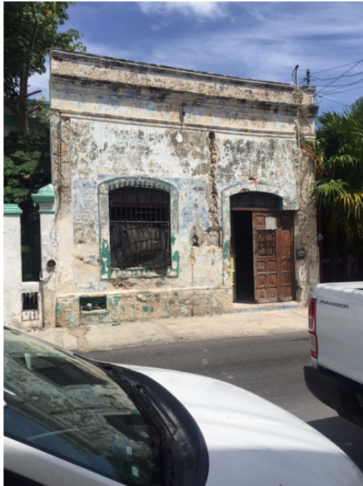
Fig. 18: Obra en remodelación (fachada) Fuente: IAMQ
