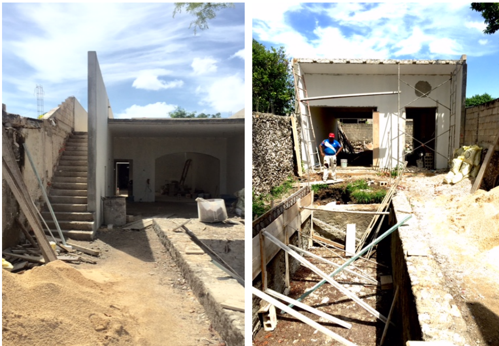
Fig. 19: Obra en remodelación (exteriores) Fuente: IAMQ
