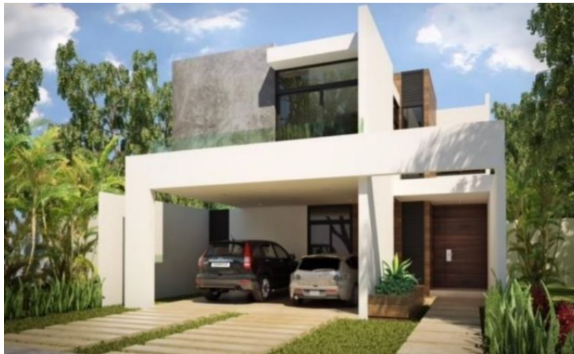
Fig. 13: Fraccionamiento Parque central. Fuente: Parque central.
