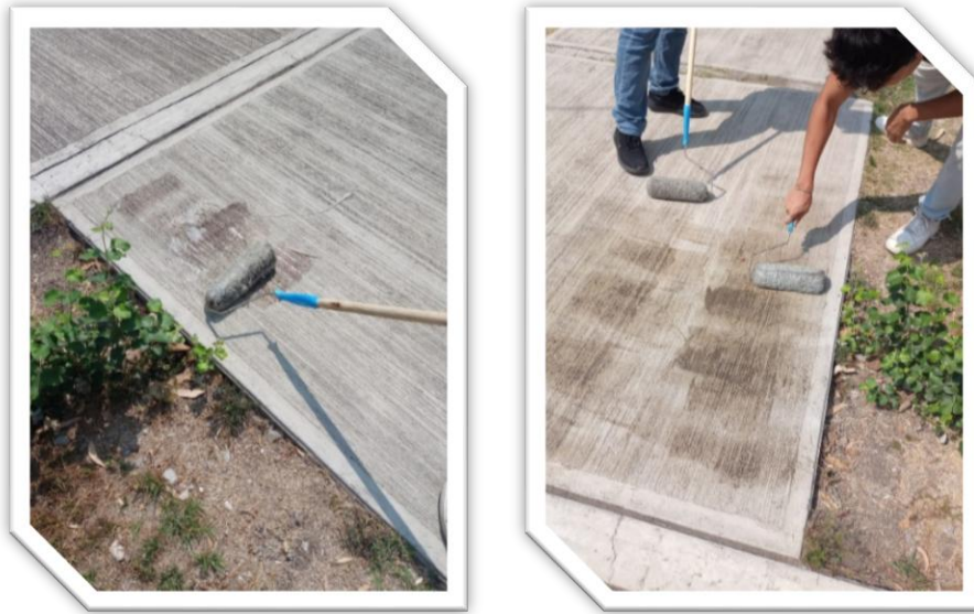
Figuras 19 y 20: Aplicación de recubrimiento.
