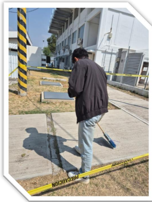
Figura 16. Preparación y limpieza del área de control.
