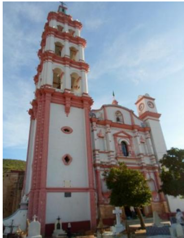
Ilustración 49 . Vista de Torre campanario, Autor Gilberto Samuel Hernández Flores (2012)
