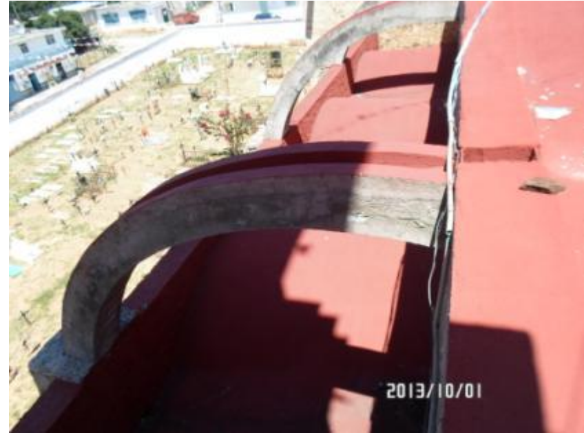
Ilustraciones 70. Detalle de contrafuertes tipo botarel, que soporta las cargas de la nave central. Autor Gilberto Samuel Hernández Flores (2013)
