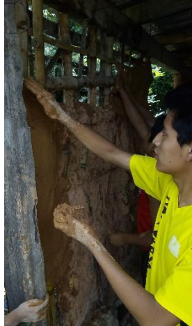
Izquierda. Actividades de bioconstrucción en el albergue del bachillerato CESIK. En la primera foto, maestros y estudiantes prepararan una mezcla a base de arcilla, paja y agua. En la segunda, estudiantes integran la mezcla a la estructura de bambú de la cocina del albergue. Junio 2018
