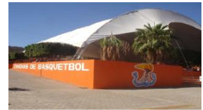
Vista de la cubierta de la cancha de Basquetbol http://www.tecomatlan.gob.mx/fotogaleria/unidad/
