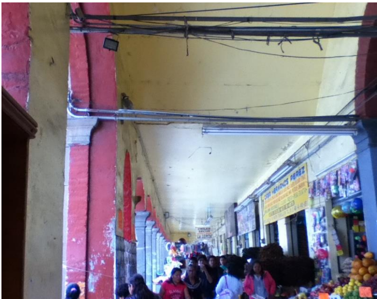
Instalacion electrica mal hubicada y en malas condiciones . Fotografía de autor 24 de Septiembre 2013
