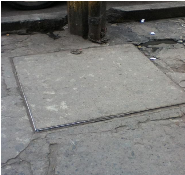
alcantarillado muestar condiciones aceptables Fotografía de autor 24 de Septiembre 2013
