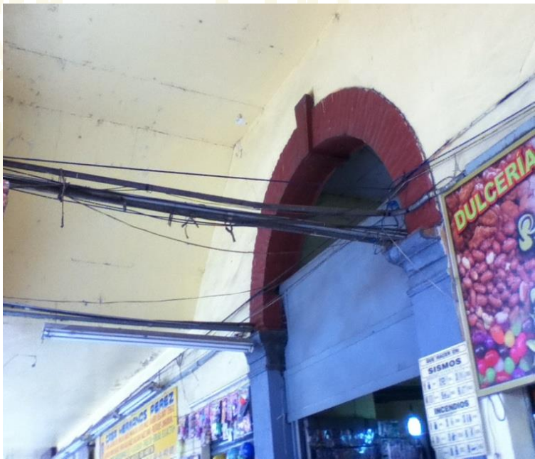
Instalacion electrica mal hubicada y en malas condiciones . Fotografía de autor 24 de Septiembre 2013
