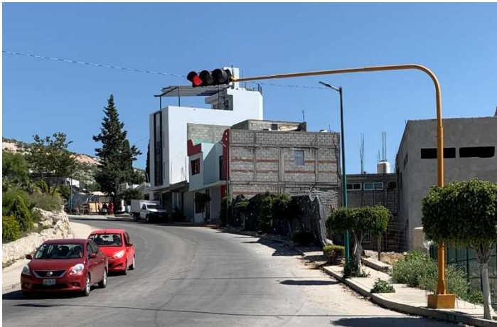
Imagen 4.2.2 Semáforo vehicular en perfecto funcionamiento, Fotografía Propia
