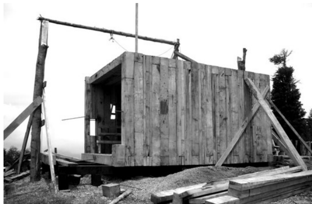
Figura 1.3.2 Pinohuacho, Chile Fuente: Grupo Talca. Proceso constructivo
