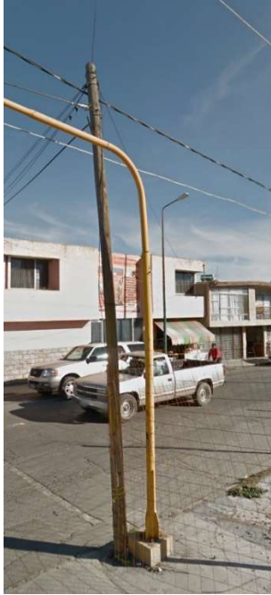
Imagen 4.2.8 Poste Calle 2 Pte. Bloquea desnivel, Fotografía propia
