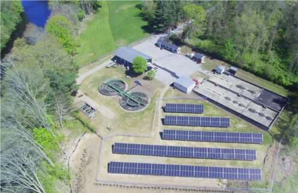
Figura 2 Ejemplo de una planta de tratamiento usando paneles fotovoltaicos, Connecticut, USA. Fuente: Greenskies Renewable Energy.
