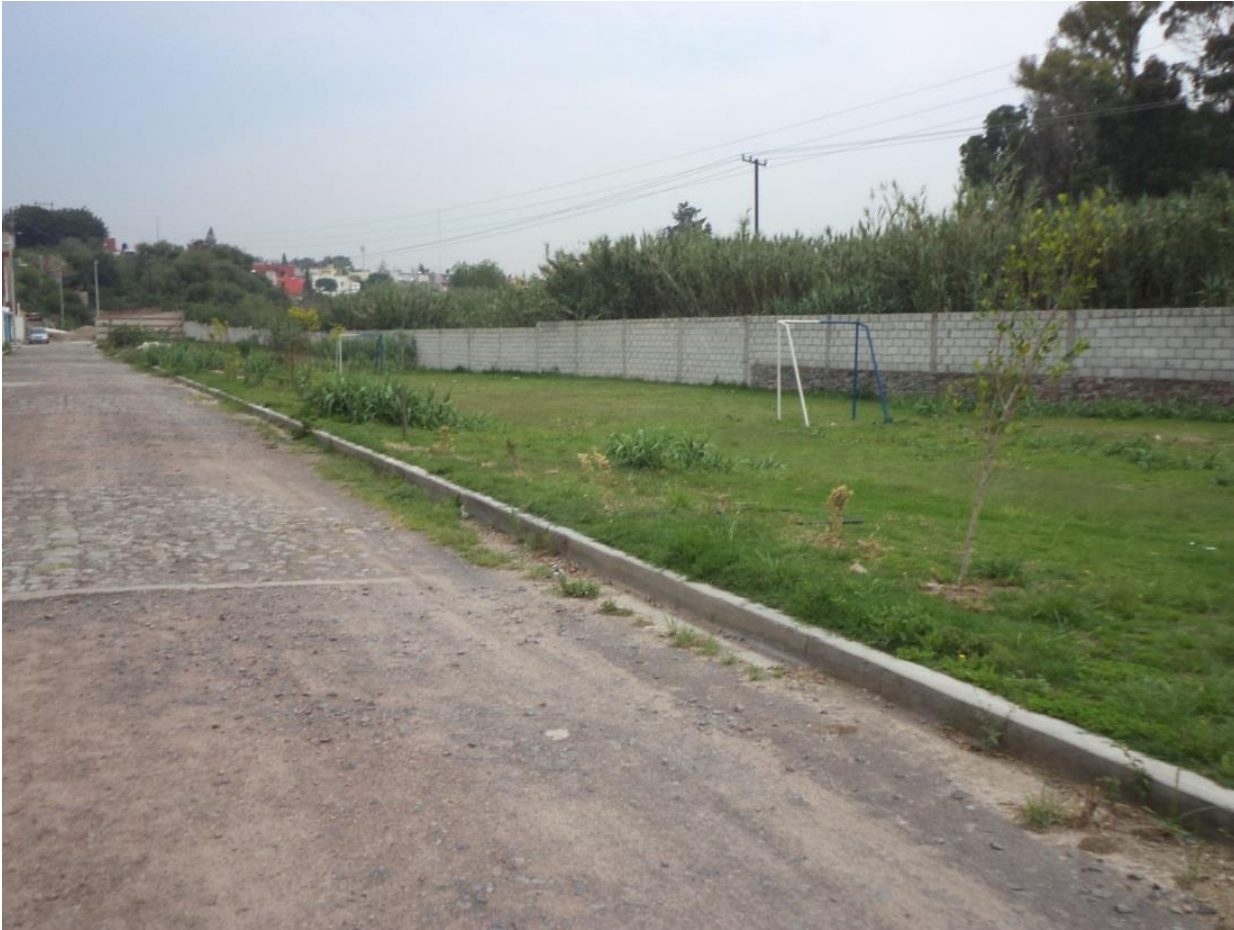
Imagen 38. Muro de protección en la colonia La Hacienda
