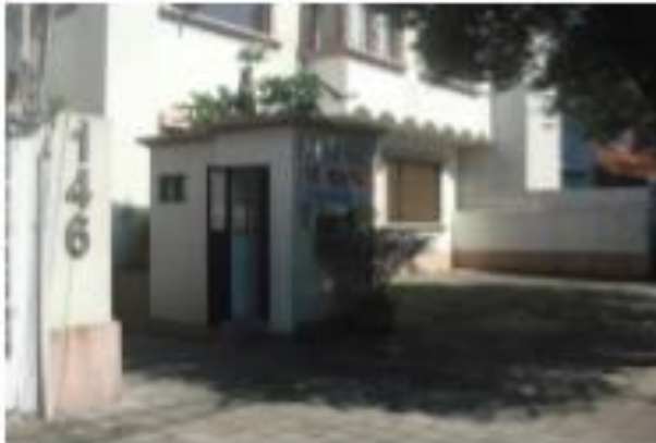
Caseta de Control.
