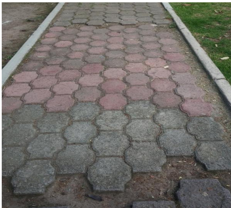
Figura 2.1. Pasillo de adoquines elaborados con jales en ITP, Pachuca, Hidalgo
