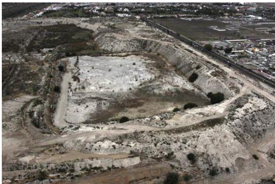
Figura 1.2. Vista aérea de presa de jal, previa a construcción del Estadio Hidalgo
