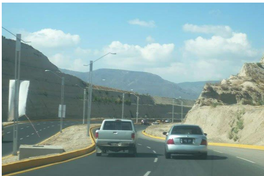
Figura 1.3. Presas de jal en Boulevard Nuevo Hidalgo
