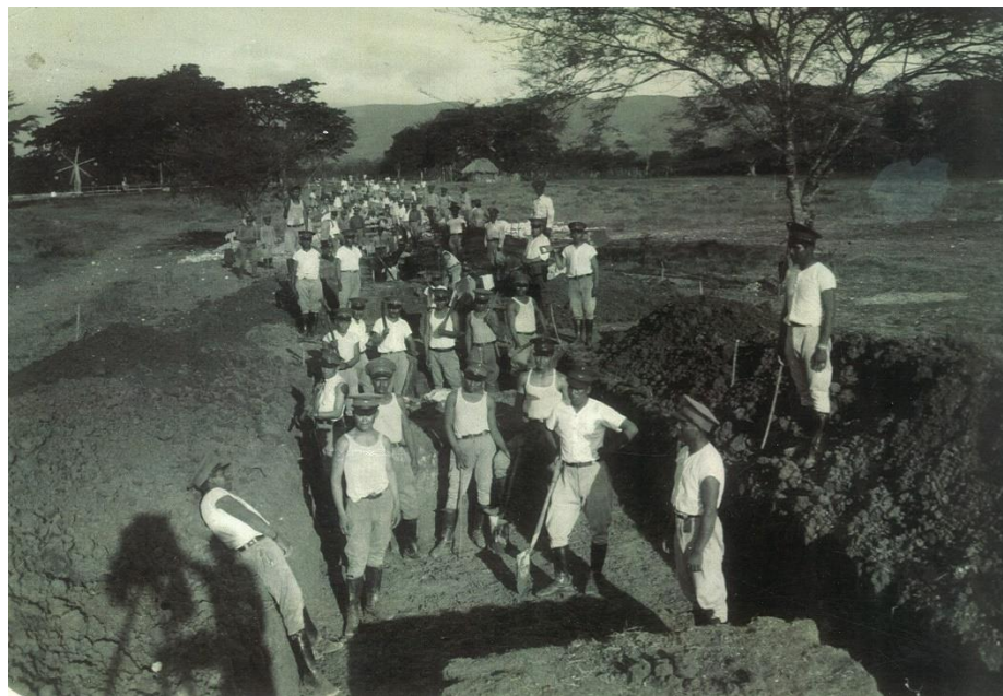
Fotografía n° 13. Elementos del 46° batallón cavando zanjas para desviar el agua de las carreteras en ciudad Ixtepec Oaxaca. Ca. 1938. Cortesía: Guadalupe Barrios López.
