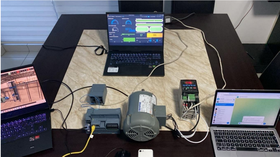
Figura 4.8. Sistema SCADA físico en funcionamiento normal.
