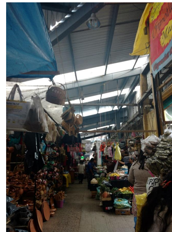
Ilustración 5 Lámina galvanizada en techo, Hernández E, 05 feb 2017
