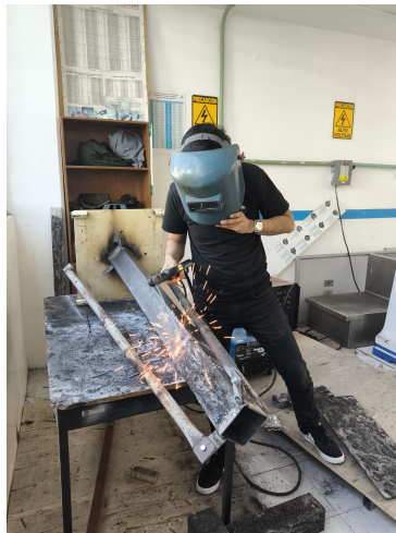
Figura 3.45: Reforzando soldadura en toda la estructura.
