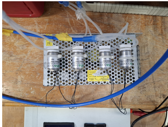
Figura 3.26: Arreglo de válvulas.
