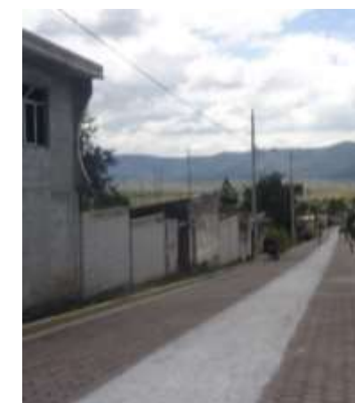
Captura Propia. Calle Emiliano Zapata con calle adoquinada
