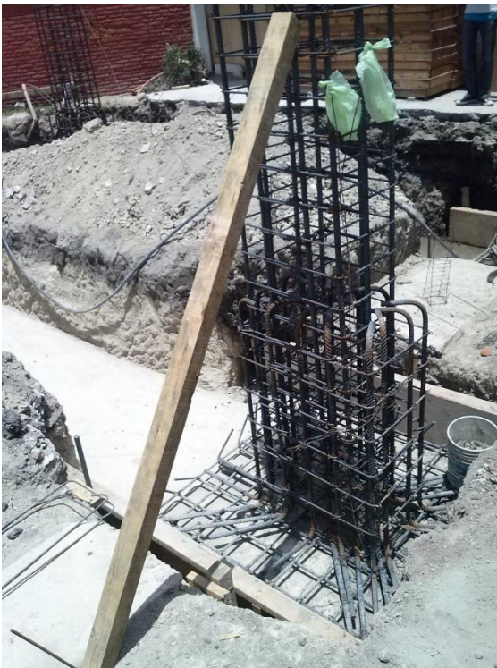
Armado de zapata aislada dado anclado a la parrilla sobre la capa plantilla de concreto pobre, en esta imagen el dado también está amarrado al armado de una columna
