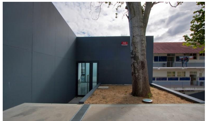
Corredor para el acceso
