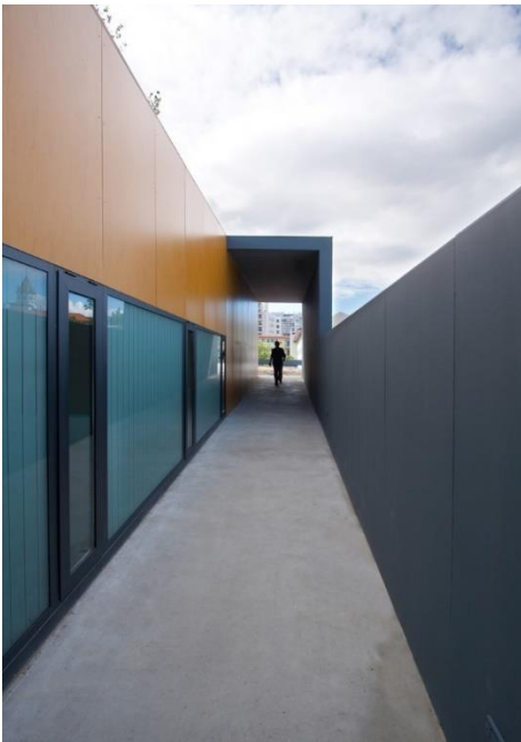
Corredor para el acceso
