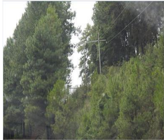
Línea San Gaspar Monumento L.T. 13.8 KV. Polígono 3 y 9
