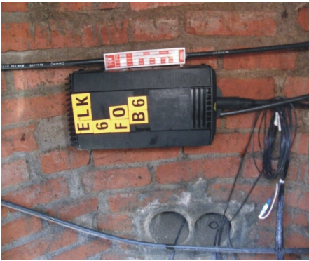
Figura 5.24: Colocación de placas y etiquetado del cierre.
