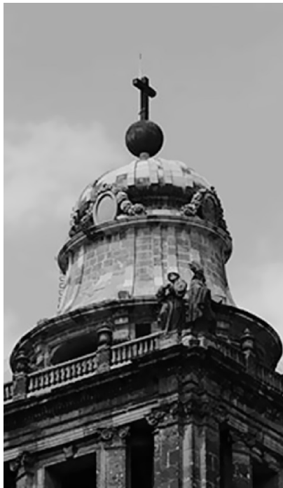
IMAGEN 1. Torre campanario de la catedral metropolitana.
