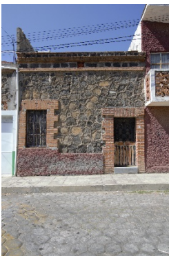
Fachada original losa plana.
