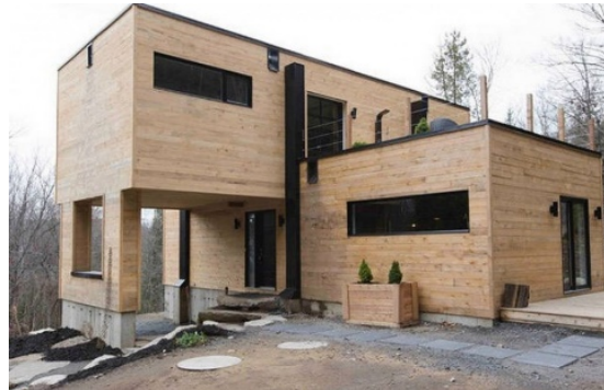
Fachada con recubrimiento de madera
