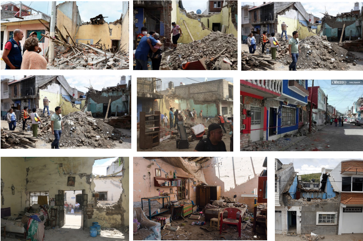
Fotos de los desastres que ocasiono el sismo del 19 de septiembre 2017 en la comunidad de Metepec.
