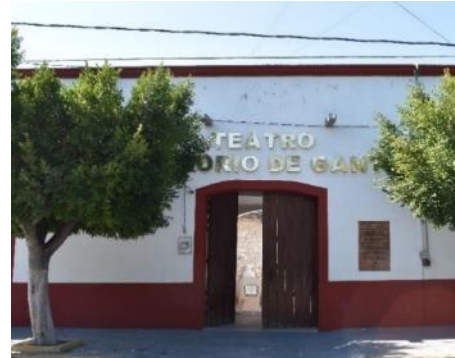
Figura 51: Av. 25 de agosto sur, ingreso inmueble Fuente: Puruncajas S., 2020
