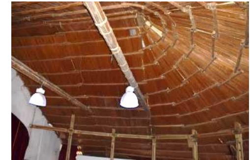
Figura 88: Vista interna cubierta galerías Fuente: Puruncajas Stephanie, 2021
