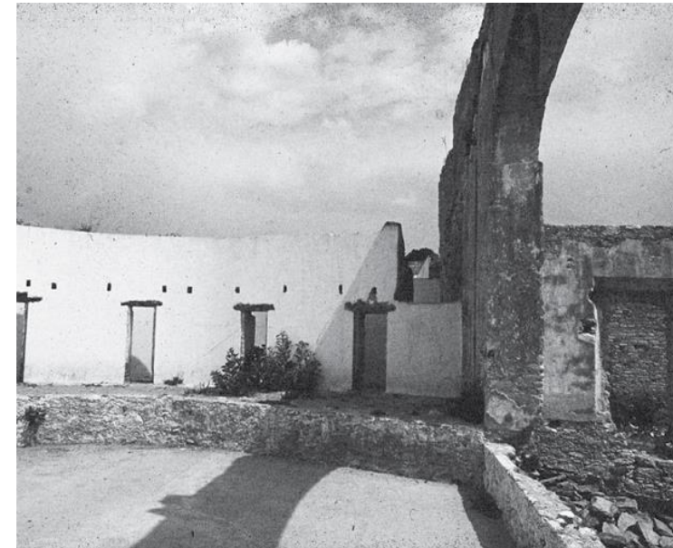
Figura 54: Estado del corral previo a la intervención Fuente: Terán, J. (2017). El corral de comedias en Tecali de Herrera
