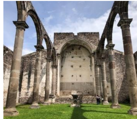
Figura 48: Ex Convento de Tecali Fuente: Puruncajas S., 2022
