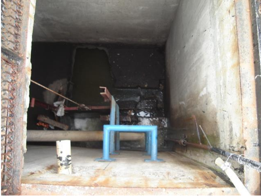
Foto de Cárcamo de recolección y bomba sumergible.
